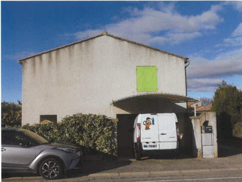
N°11-FACADE EST ET ENTREE PRINCIPALE DU GARAGE-
